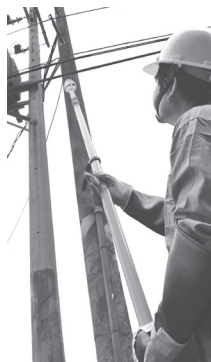
Fig. 3: Detección de voltaje en líneas aéreas
